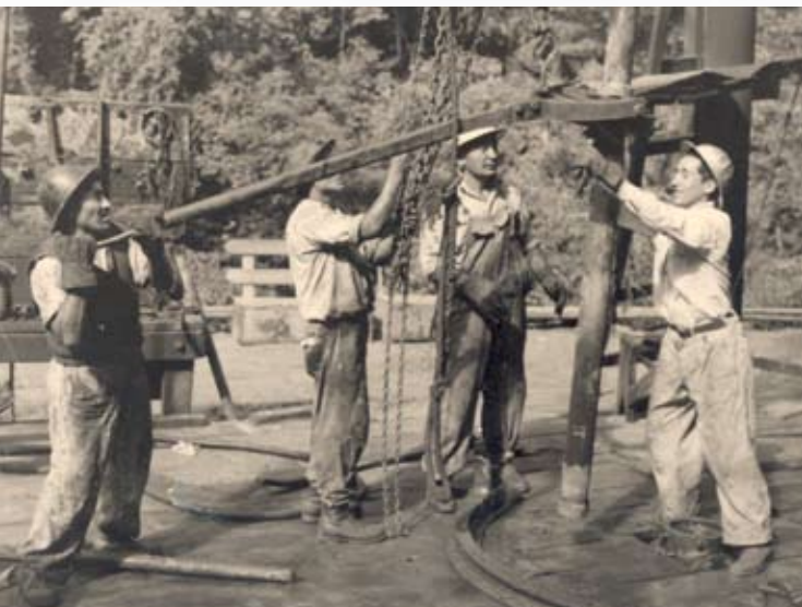
Trabajadores petroleros realizan un ajuste de barras de sondeo, durante una maniobra de perforación.
